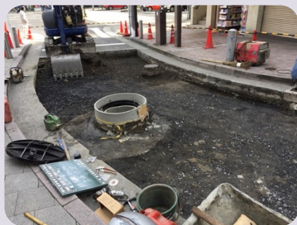
麻布十番駅近くのパティオ通りの修繕
